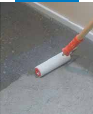
Aplicación de Primer G con rodillo
