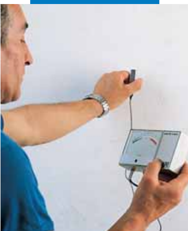
Comprobación de la humedad del yeso
