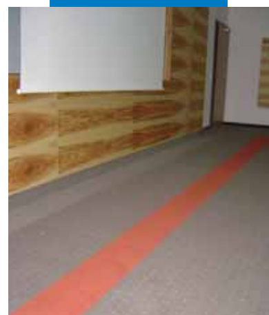
Ejemplo de uso de Primer G antes de la colocación de Ultraplan Eco y del adhesivo Rollcoll , para el encolado de la moqueta en las habitaciones del hotel - Villa Hotel Castellani - Austria
